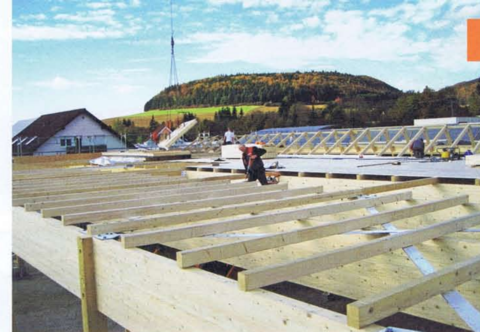
▶ Zug um Zug wird das Dach geschlossen
