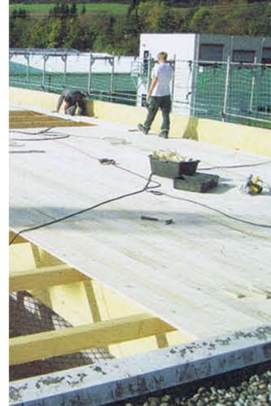
◀ Das Dach bekommt zunächst eine Holzschalung – bis zu den Sheds
